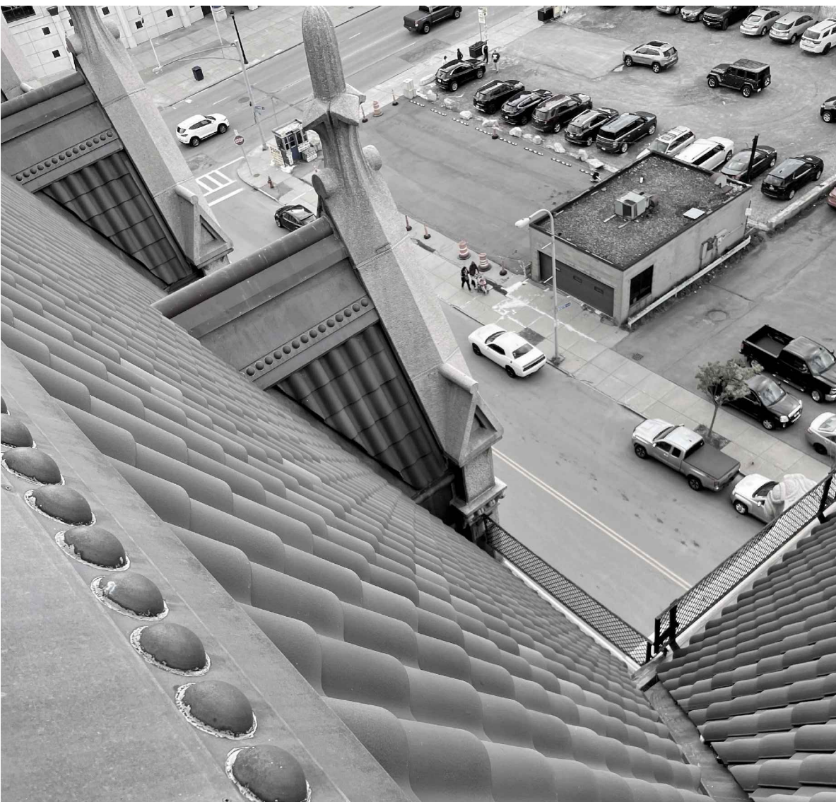
3 SNOW GUARDS - WEST SIDE SCALE: N.T.S.
